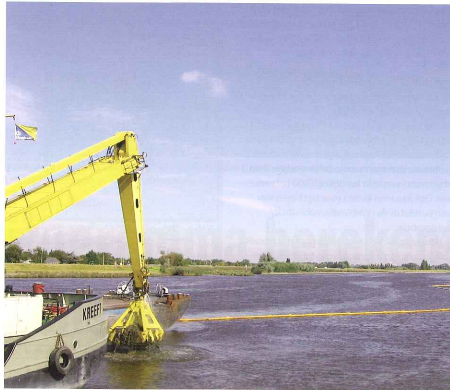
Begin van de werkzaamheden voor de herontwikkeling van de afgebroken Zellingwijk: ontgraven van de locatie, februari 2008.
