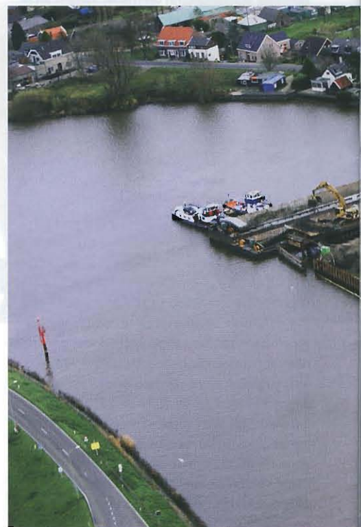
De bodemsanering in het laatste stadium in november 2009. Bij de tijdelijke laad- en losfaciliteit (boven) worden de laatste resten verontreinigd stortmateriaal geladen in beunbakken en wordt schoon zand gelost. In de groene loods is de grondwaterzuiveringsinstallatie gehuisvest.
